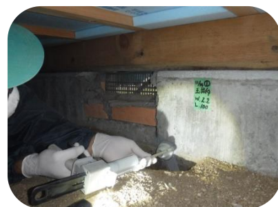
エポキシ樹脂を注入
