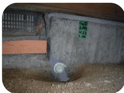
注入ドーム設置
